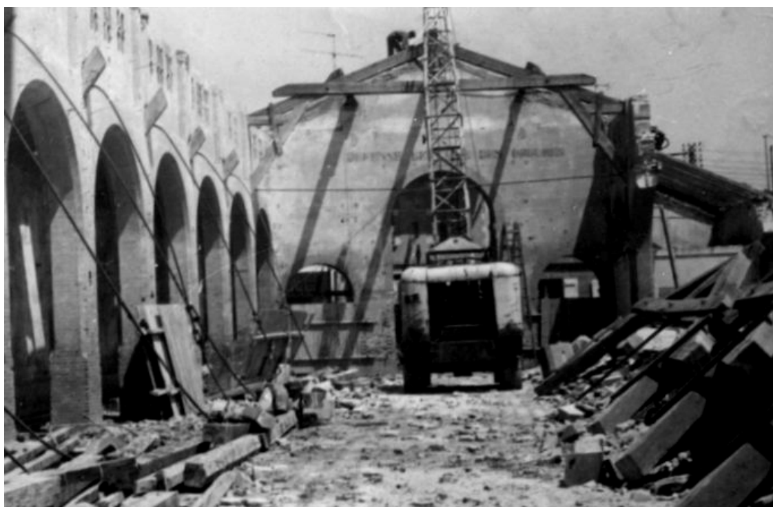
Démolition de la Halle aux étalagistes en 1970-71.
